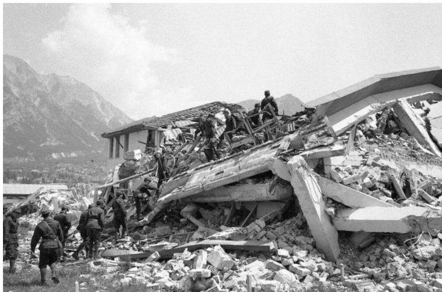
La distruzione dopo il 6 maggio 1976.
